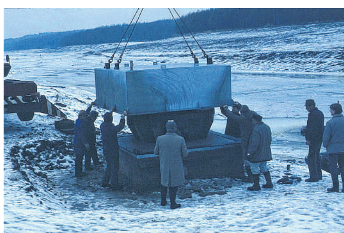
Probeversuch mit der Stahlhaube: Im trockenen Zustand klappte es, die Konstruktion über das Ablassbauwerk zu stülpen.
