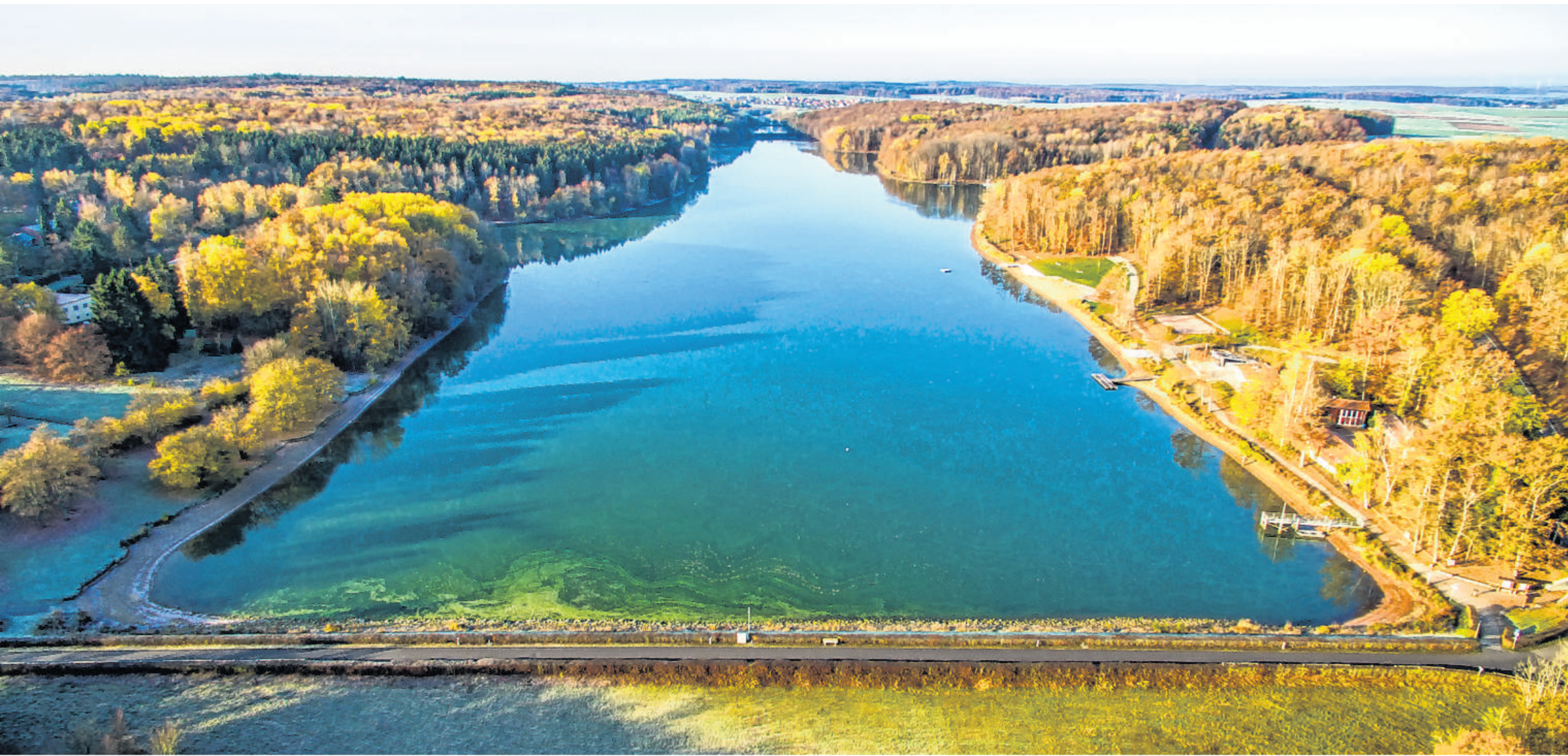
Protest wird laut gegen das Ablassen des Ellertshäuser Sees. Das Wasserwirtschaftsamt will die Talsperre trockenlegen, um die technischen Betriebseinrichtungen zu sanieren.
