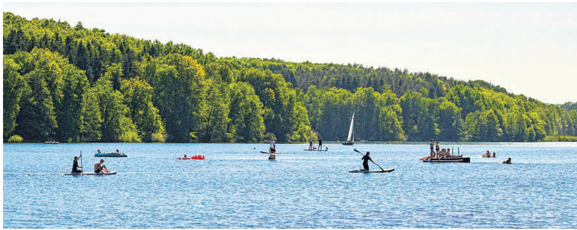
Baden, segeln und paddeln ist nur noch in dieser Sommersaison am Ellertshäuser See möglich. Im Herbst soll das Wasser abgelassen werden, um die technischen Betriebseinrichtungen zu sanieren und den Stausee zu entschlammen.
